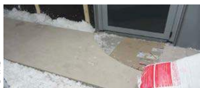
L'isolant situé derrière la porte a été enlevé pour permettre son ouverture
